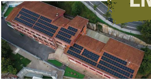
PLACAS SOLARES DE GAINZURI
